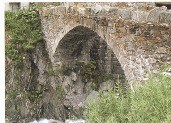
Pont à Wassen, Uri
