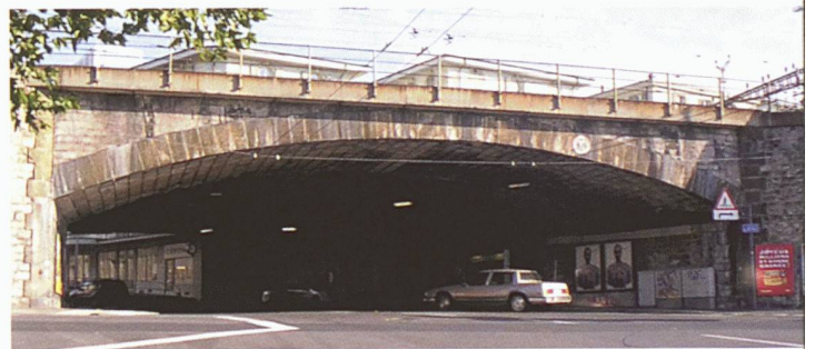
Les viaducs d'Ouchy, Lausanne
