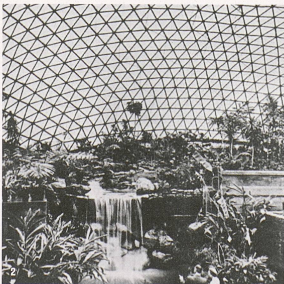
2 Anfang der 1950er-Jahre begann Richard Buckminster Fuller geo- dätische Kuppeln zu bauen, die er patentieren liess. Honolulu 1957
