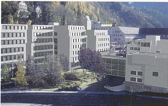
Mit Aussendämmung eingepackt (Bauengineering / Hubert Bischoff)
