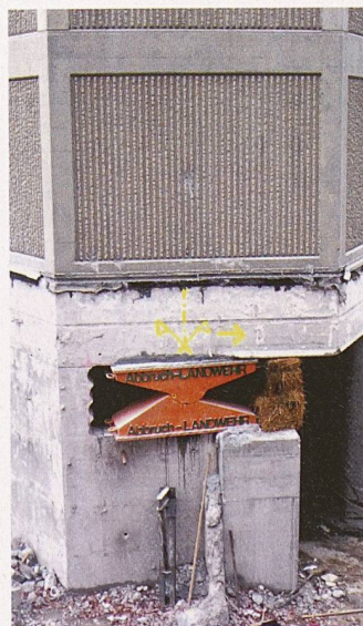
Eines der 2 Stahlkippgelenke im Turmfuss, links Beton-Restquerschnitt
