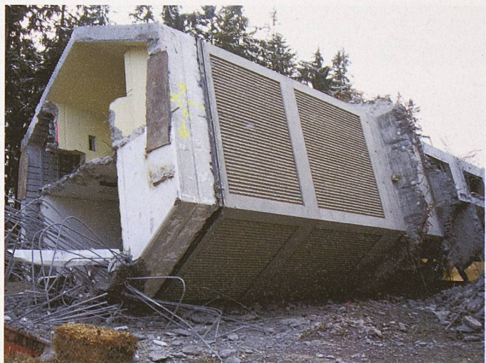
Unten die Sprengenebene im Restquerschnitt (Bild: Nicolas Contesse)
