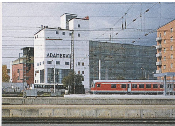
Neu im ehemaligen Sudhaus «Adambrau» in Innsbruck: das Archiv für Baukunst (Bild: Nikolaus Schletterer)
