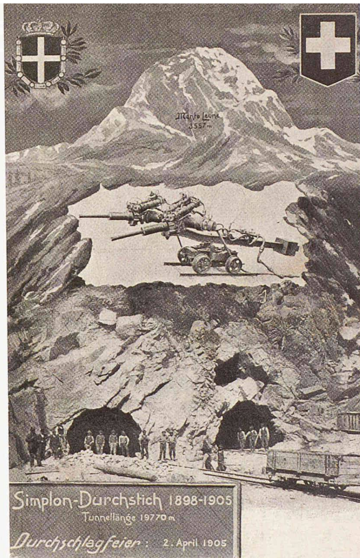
Ansichtskarte von der offiziellen Durchschlagsfeier des Simplontunnels am 2. April 1905. Im Zentrum ist eine der am Simplon erstmals verwendeten, mit Druckwasser betriebenen Drehbohrmaschinen zu sehen (Bild: Archiv Autor)
