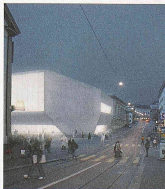
Reduzierte Formensprache und eine Fassade aus geschliffenem, mit weissen Zuschlagstoffen vermengtem Beton (Morger & Degelo)
