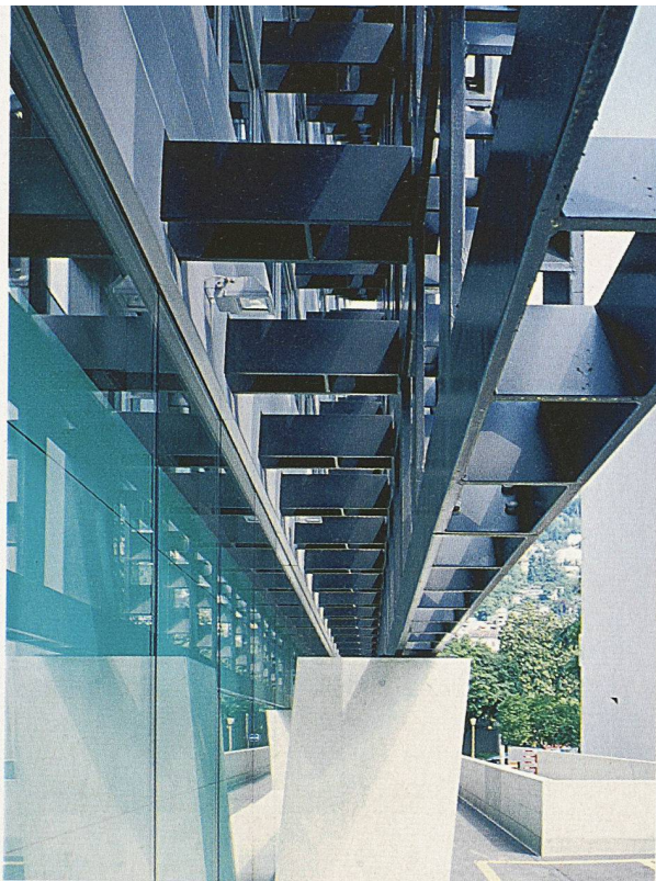
Europäischer Stahlbaupreis: Geschäftshaus in Locarno. Die Geschossdecken sind an der aussen liegenden Tragstruktur aufgehängt (Bild: Hans Ege)
