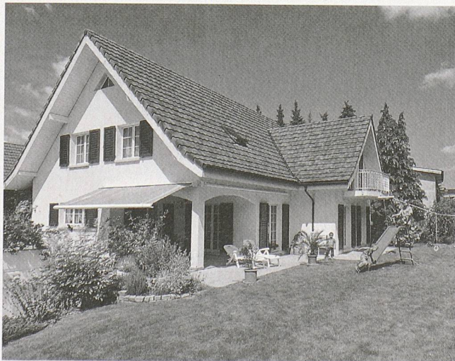
Kinderspielplatz: Eine in die Erde verlegte Tankanlage lässt viel Raum.
