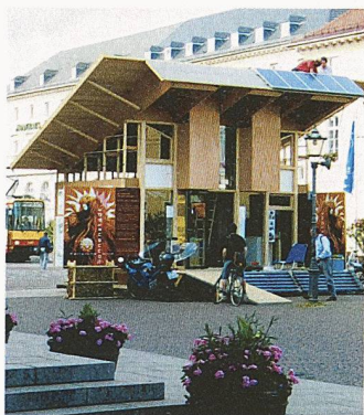
Experiment-Sonnenhaus aus Materialien wie Strohballen, Holz oder Glas (Bild: Verein Sonnenstadt Karlsruhe)
