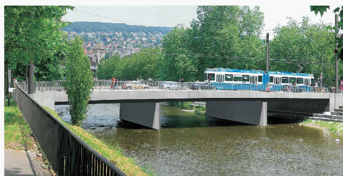
Bestehende Pfeiler und Widerlager werden grösstenteils wiederverwendet (Team Marti)
