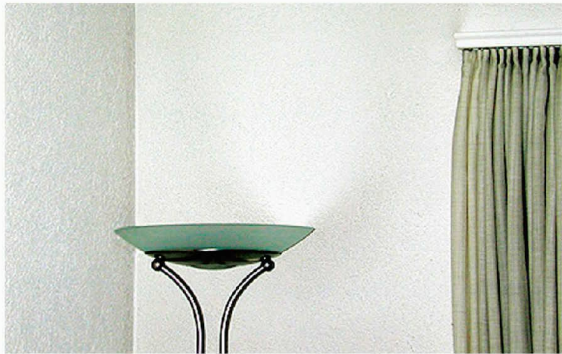
Typisches Schadenbild in einer Wohnung. Die schwarzen Ablagerungen sind deutlich sichtbar (Bild: Empa)
