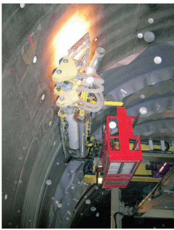
Maschinelles Verkleben der Dichtungsfolien im Isisbergtunnel ZH (Bild: Autor)
