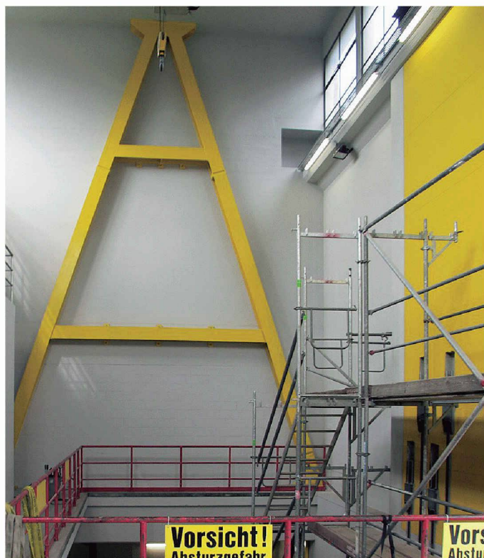
Erdbebenertüchtigung in einem Unterwerk mit Stahlfachwerk (hinten, gelb) und mit Stahlbetontragwand (rechts, gelb) (Bild: Thomas Wenk)
