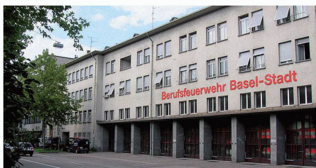
Erdbebenertüchtigt: Gebäude Lützelhof, Berufsfeuerwehr Basel-Stadt (Bild: A. Zachmann)
