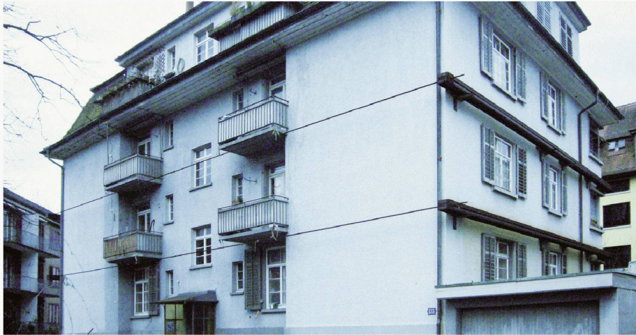
Mittels Zugband gesichert: Mehrfamilienhaus an der Uetlibergstrasse 149 in Zürich (Bild: cvr/TEC21)
