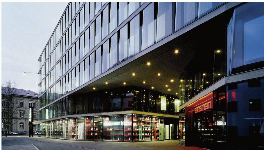
AZ-Medienhaus in der Altstadt von Aarau: Kosten, Termine und Qualität im Griff dank Kostengarantievertrag SIA/BSA (Bild: Roger Frei, Zürich)
