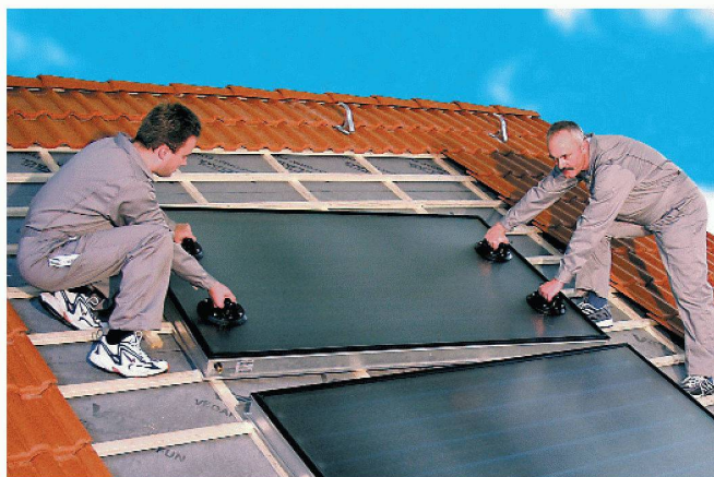
Die ideale Kombination: Ölheizung und Solaranlage; dank standardisierten Komponenten ist die Montage sehr einfach.
