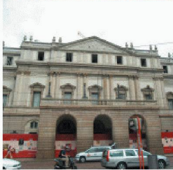
Neubauten in und an bestehenden Bauten
