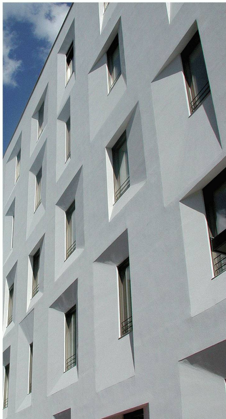
Bei diesem Umbau zu einem Passivhaus-Verwaltungsgebäude für die Autonome Provinz Bozen machten die Architekten aus der Not der dicken Dämmung eine Tugend. Unterschiedlich angeschrägte Leibungen bringen die Rasterfassade in Bewegung (Bild: Michael Tribus Architecture)
