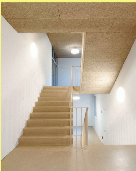
04 Der Neubau ist, um ein halbes Geschoss nach unten versetzt, im Treppenhaus mit dem Altbau verbunden
