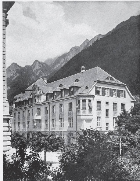
DIE GRAUBÜNDNER KANTONALBANK IN CHUR ARCHITECTEN B. S. A. SCHÄFER & RISCH, CHUR Südwestlicher Flügel an der Grabenstrasse
