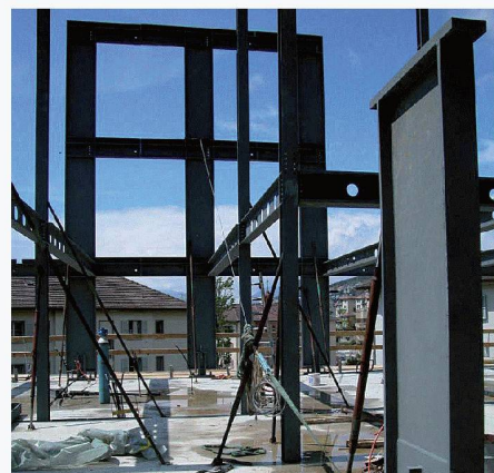
Die Erdbebenkräfte der Zone 1 erfordern ein massives Stahltragwerk
