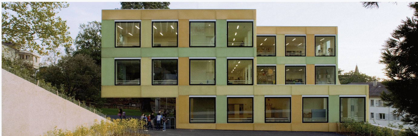
Prämiertes Schulhaus in Neuenburg von Andrea Bassi, Architekt, und Guscetti & Tournier, Ingenieure: Das Erdgeschoss und die Obergeschosse sind als Stahlverbundkonstruktion mit Glas- und Leichtfassade ausgebildet (Bilder: Guscetti & Tournier)
