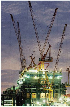
Baukräne auf einem Hochhaus in Dubai (KEYSTONE/CARO/Sorge)
