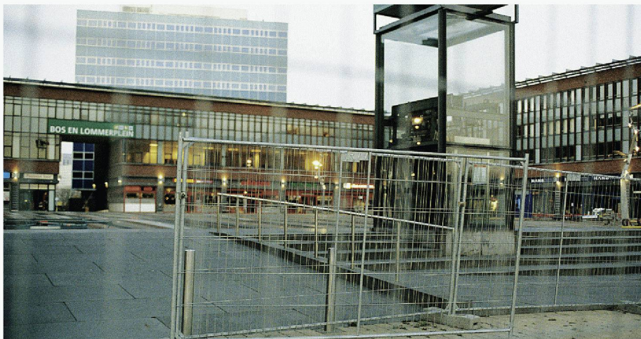
Noträumung wegen sicherheitsrelevanter Bau- fehler: Einkaufszentrum «Bos en Lommerplein» in Amsterdam (Bild: Autor)
