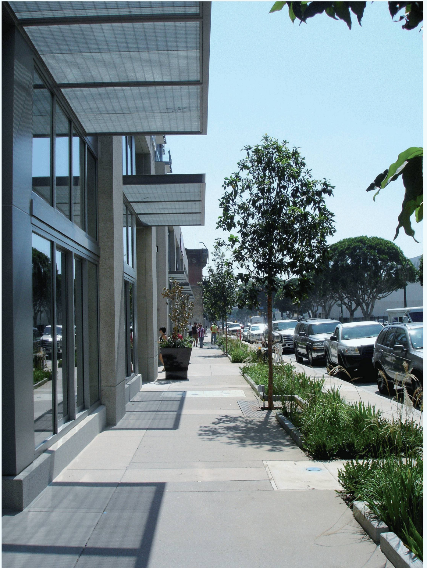
02 Das Trottoir vor dem neuen Luma-Gebäude von Ankom Moisan ist begrünt und mit einer Abwasserfilteranlage ausgestattet (Bild: Lilian Pfaff)
