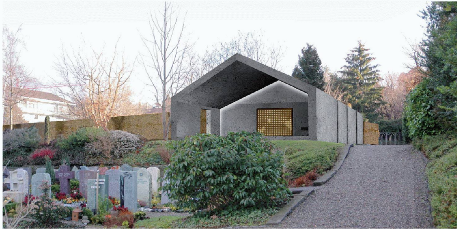
06 Lichtschlitze teilen die Betonhülle und erzeugen eine sakrale Stimmung im Inneren (2. Preis: Projekt «Mauer und Haus»; EM2N, Zürich)
