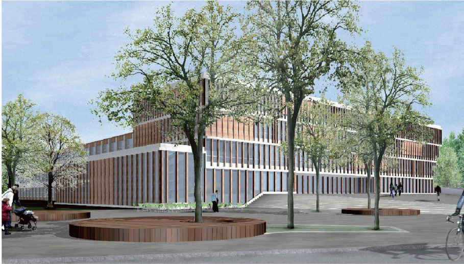
01 Siegerprojekt mit «Strassencafé» – neben dem Haupteingang der Schule (und nicht in der Fussgängerzone) ist die Terrasse der Schulmensa ein sonniger Präsentierteller (1. Preis, huggen_berger & Erika Fries, Architektin, Zürich)
