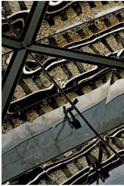
Die Dachuntersicht der Expo-MRT-Station von Changi reflektiert Licht auf die Bahnsteige (Bild aus: Will Pryce «Kolossale Konstruktionen». Siehe Rezension S. 17)
