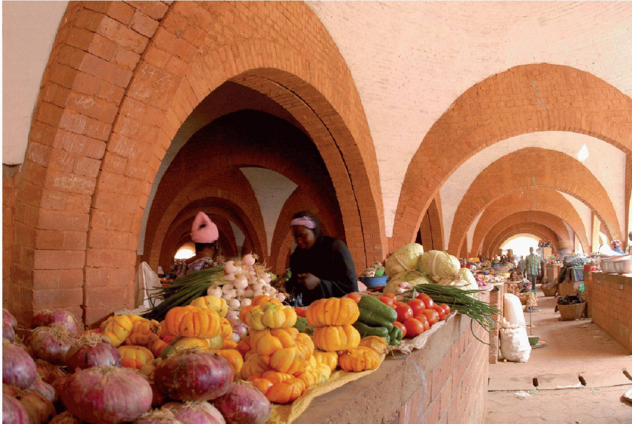
01 Kuppelkonstruktionen aus Lehmziegeln beherbergen die Marktstände (Bild: Amir-Massoud Anoushfar/ Aga Khan Award for Architecture)
