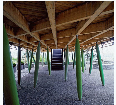
Würdigung der Tätigkeit für Holz: Marianne Burkhalter und Christian Sumi. Beispiel: Hotel Rigiblick, Zürich (Bild: Heinrich Helfenstein)
