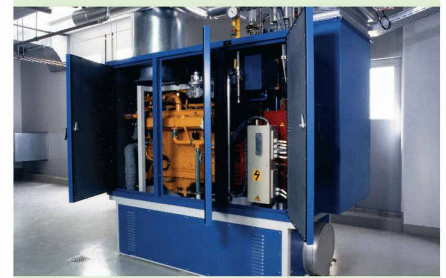
Gasmotor-Blockheizkraftwerk (BHKW)
