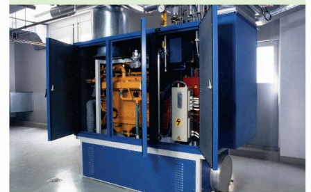
Gasmotor-Blockheizkraftwerk (BHKW)
