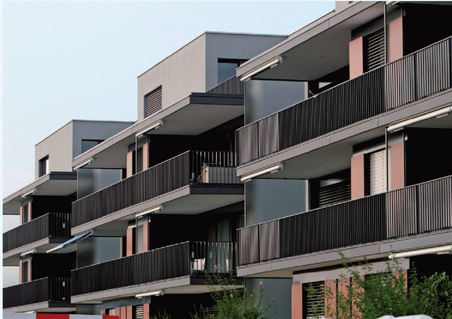
Die Überbauung «Im Weidli» in Baar – neu wird sie «Rote Trotte» genannt – ist komplett mit Glasfasern erschlossen. Seit Juni dieses Jahres ist die Überbauung im Netzwerk aufgeschaltet (Bild: Rossi Architekten, Zug)
