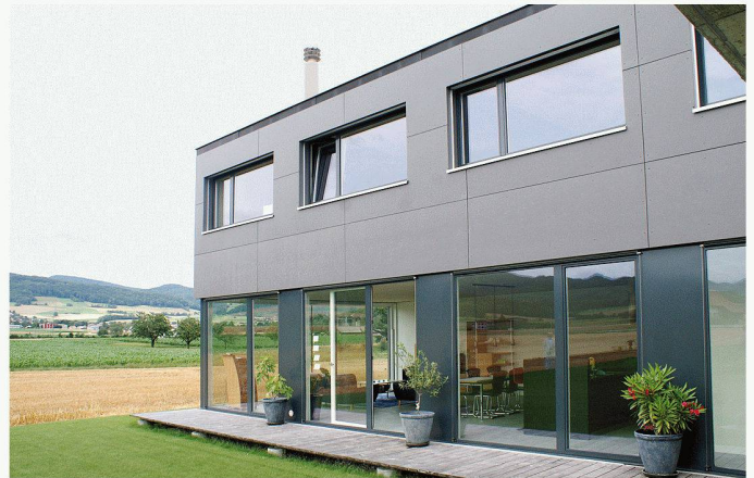
02 Wand- und Deckenkonstruktion bestehen aus Holz, den Charakter des Hauses prägen dunkelgraue Fassaden- und weisse Gipskartonplatten
