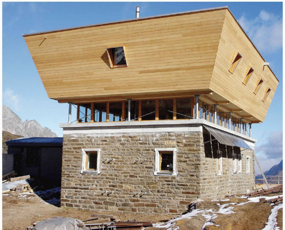
...und nach dem Umbau. Ob Änderung, Werk zweiter Hand oder einfaches Werk der Baukunst: Die Antwort wird dem Leser überlassen (Bild: W. Maffioletti)
