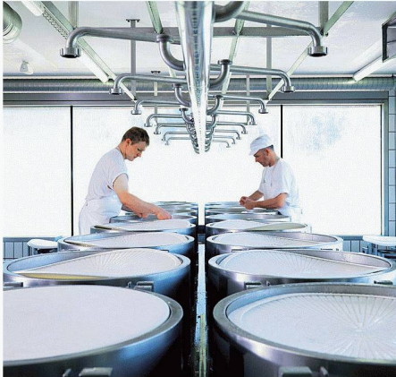
01 In der Spezialitätenkäserei wird schweizweit erstmals die Wärme eines Holzschnitzelofens genutzt, um eine Absorptionskältemaschine zu betreiben (Bild: Stiftung Klimarappen)
