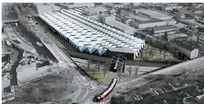
06 «Do-desu-ka-den». Kleinteilige Stahlbaumodule bedecken das Gelände wie ein Teppich (Ernst Basler + Partner, Atelier 5)
