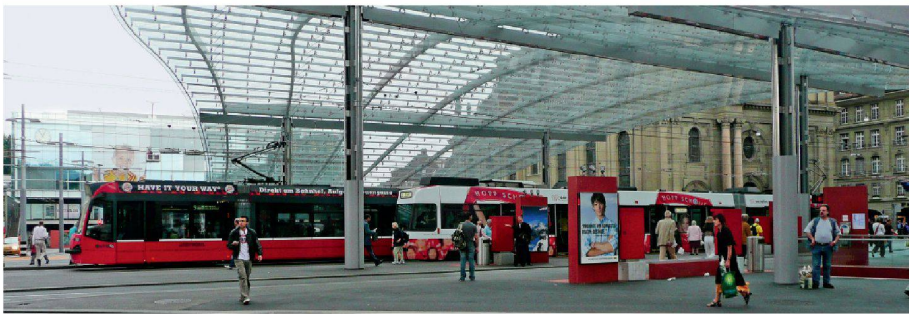
02+03 Der Baldachin von der Altstadt aus sowie Blick Richtung Bahnhof und Heiliggeistkirche
