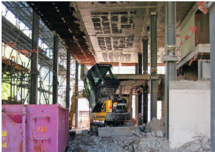
04 Rück- und Umbau des Zwischengeschosses, das neu bis zu den peripheren, hier noch zweigeschossigen Fassadenpfeilern reichen soll, erforderten eine detaillierte Planung der Etappierung (Bild: Paul Lüchinger)
