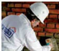
2. Aufbringen der Haftbrücke mit Remmers Sulfatexschlämme schnell während der Kiesel-Reaktionszeit.
