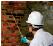
1. 09:30 Uhr: Grundierung des vorbereiteten Untergrundes mit Kiesel 1:1 mit Wasser. Stark saugende Untergründe sind vorzunässen.
