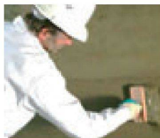
5. + 6. 10:00 Uhr: Im Schlämm- oder Spachtelverfahren wird die Remmers Sulfatexschlämme schnell je nach Lastfall in zwei oder drei Abdichtungsschichten frisch in frisch aufgebracht.
