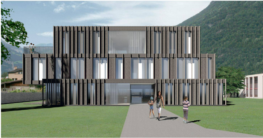
01 Siegerprojekt «Ringelreihe»: Die Geschosse sind kreuzweise gestapelt und etwas versetzt, um die Höhe zu brechen und Terrasse zu schaffen (Visualisierung: Graber & Steiger, Luzern)
