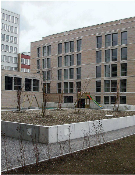
01 Siedlung Eulachhof, Winterthur: Für die Nullenergie-Überbauung wurde Holz in der Konstruktion, im Ausbau und an der Fassade verwendet (Bild: Michael Meuter, Lignum)
