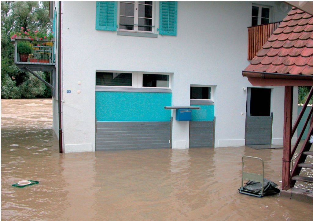
Die von der Reuss umspülte Liegenschaft Riegger in Mellingen (AG) blieb dank den mit dem WP WASTO-Hochwasserschutz-System abgeschotteten Türen und Toren vor grösseren Schäden bewahrt.
