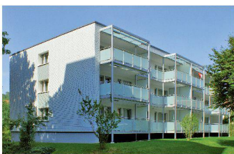
Hinterlüftete Eternitfassaden sind qualitativ hochstehend und beständig – einmal gebaut, bleiben sie Jahrzehnte intakt.
