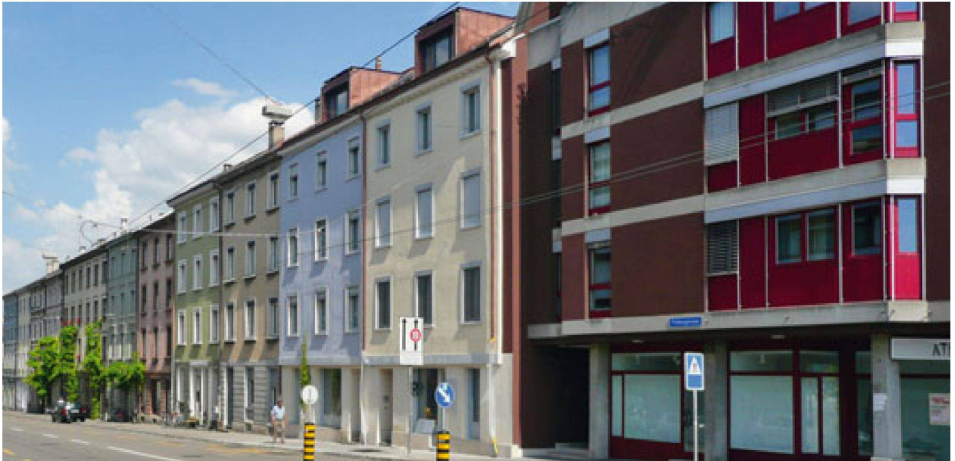
01 Die beiden Mehrfamilienhäuser an der Feldbergstrasse in Basel (zweites und drittes Haus von rechts) wurden von den Architekten Viridén + Partner (Zürich) saniert. Sie gehören zu den Projekten, die mit dem diesjährigen Solarpreis in der Kategorie Gebäude ausgezeichnet wurden (Foto: js/Red.)
