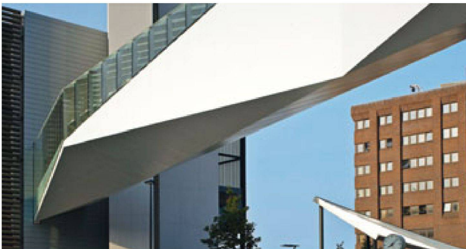
01 Ausgezeichnet: die «Pedestrian Footbridge» in Liverpool GB (Foto: Tuchs Schmid AG)
