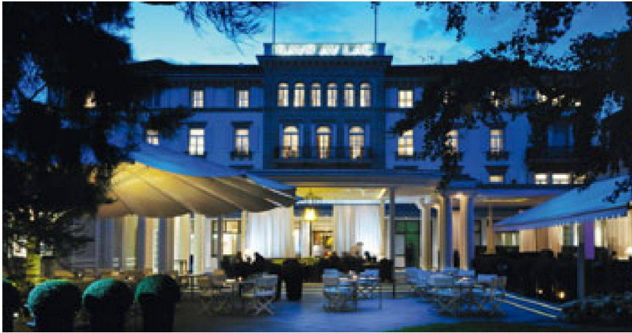
01 Hotel «Baur au Lac», Zürich (Foto: Implenja AG)
