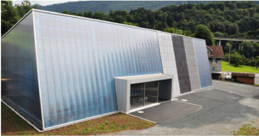
01 Schmidlins Bau- und Schulungslabor (Foto: Schmidlin AG)
