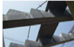
Bild 3: Tribünetragkonstruktion: Die Sägezahnträger
