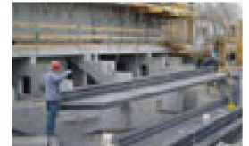
Bild 4: Versetzen der Elemente durch die BRUN-eigene Montageequipe
