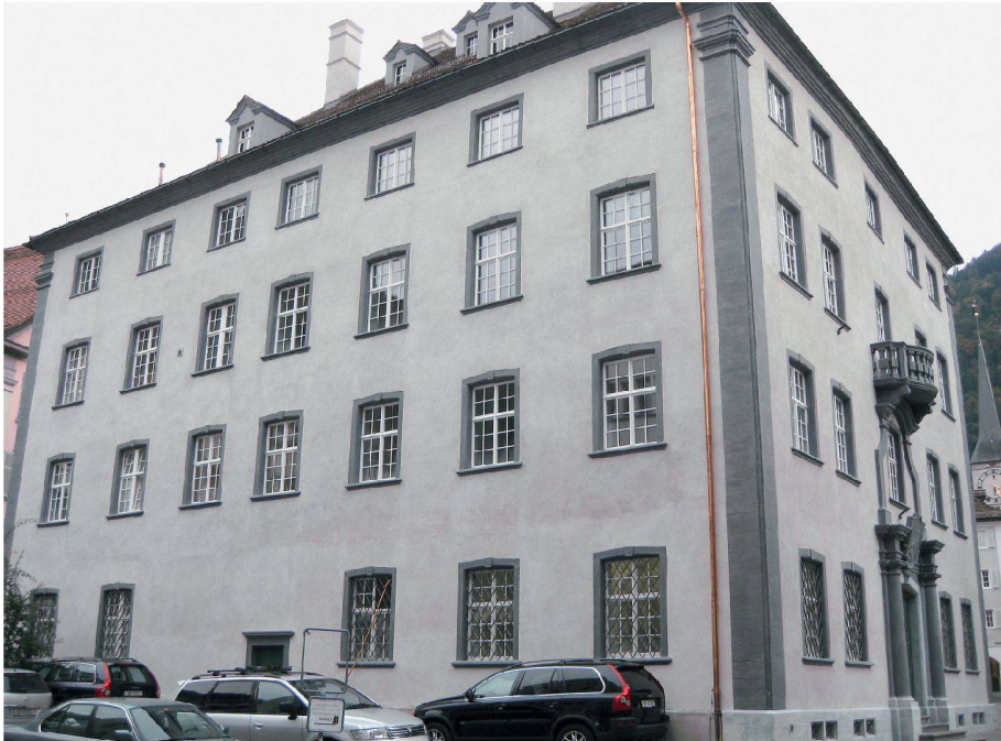
01 Ecke Nordwestfassade des Bündner Regierungsgebäudes in Chur (Foto: ms/Red.)
