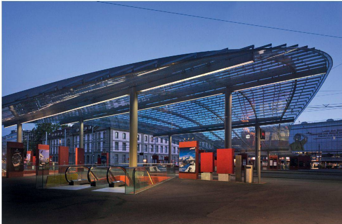
01 Welle, Bern: viel diskutierte Stahlkonstruktion aus sechs Kastenträgern auf zwölf eingespannten Stahlstützen und quer verlaufenden, zweifach gekrümmten Sekundärträgern (Bild: Tuchschild / Alexander Gempeler, Bern)
