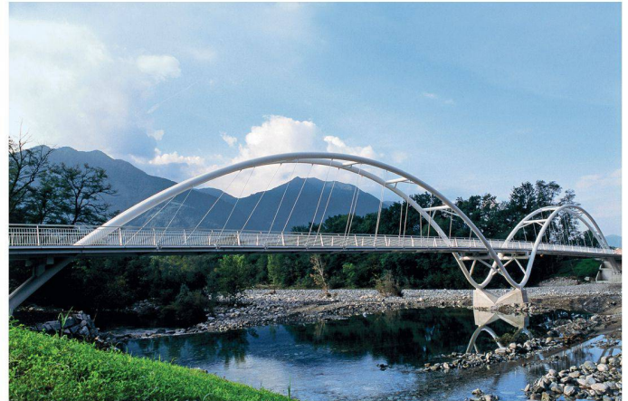
02 Doppelwelle über die Verzasca, Tenero / Gordola: Eine alte Steinbrücke über die Verzasca gab die Form für die 120 m lange Stahlbrücke aus zwei gebogenen Rundrohren (Bild: Danny Noel, Agarone)
