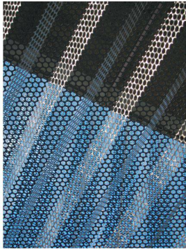
Das wird es nur noch im Stau zu sehen geben: Blick von der Fahrbahn nach oben auf die Lochblech-Hülle der Raststätte Affoltern am Albis (Foto: af/Red.)
